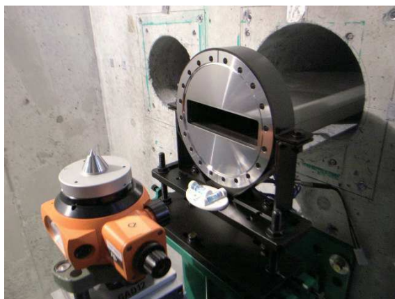
図1 大きくした遮へい壁貫通口 (250 mmφ) と設置中のビームダクト (150 mm(W)×40 mm(H))。奥に見える貫通口はビームライン BL09B 用のもの。後に、十分な厚みの鉛で埋めもどされる。
