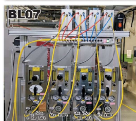
BL07では4本、BL11では6本のガスボンベを接続して運用している（2021年度にBL07に低エネルギー用に3本追加予定）。
